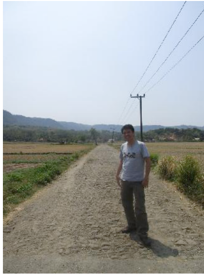
Gambar 4.11 Batas Antara Jalan yang Rusak pada Jalan Poros Tengah Kawasan Citamansakti
