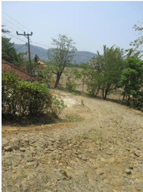
Gambar 5.3. Kondisi jalan poros tengah yang penuh bebatuan
