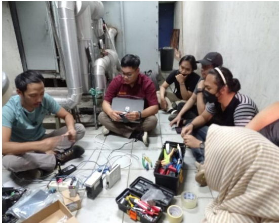
Gambar 5. Instalasi Kabel UTP
